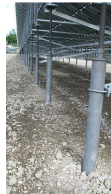
鋼製杭と砕石・再生骨材による地盤対策の効果を検証します。
