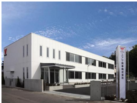
建物には断熱材やALCパネル、ペアガラスを採用し、建物全体の断熱性を高め、空調負荷の低減に配慮しています。
