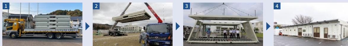
フラットバック型の医療コンテナのため、輸送時の利便性を高めながら組立時間の短縮が可能です。新上五島町では5つのコンテナ棟がわずか1日で、3人での作業により組立・微調整が完了しました。当社グループが有する現場力により、輸送・設置・撤去・工事までワンストップで対応可能です。
