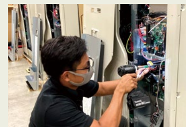
当社の関東物流センター内で行っている専門技術者による空調機改裝作業の様子
