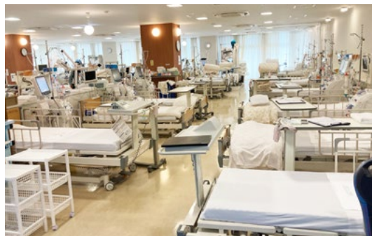
医療施設におけるLED照明の導入
