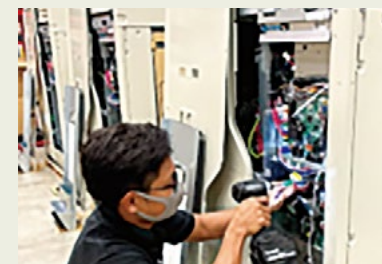
当社の関東物流センター内で行っている専門技術者による空調機改裝作業の様子
