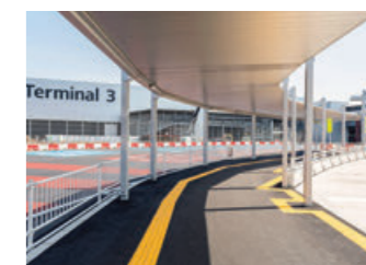
成田国際空港第三ターミナル シェルター
