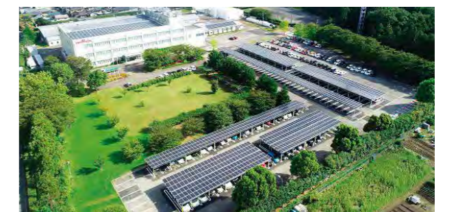
当社が100%再生可能エネルギー利用工場化をご支援させていただいた(株)金津村田製作所(福井県)
