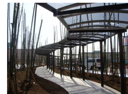
東洋産業が施工を担当したシエルト回廊工事（千葉県内）
