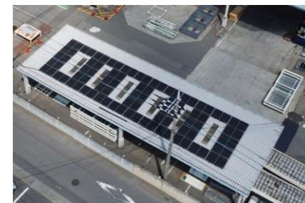
【写真】当社グループ会社・富士クオリティハウス(群馬県伊勢崎市)の敷地内 資材置き場屋根に設置した太陽光パネル
