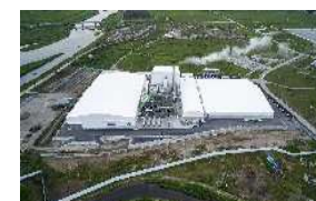
浪江町 仮設焼却施設
