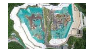
特定廃棄物埋立処分場
