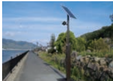
「スマートタウン」に欠かせないソーラー街路灯
